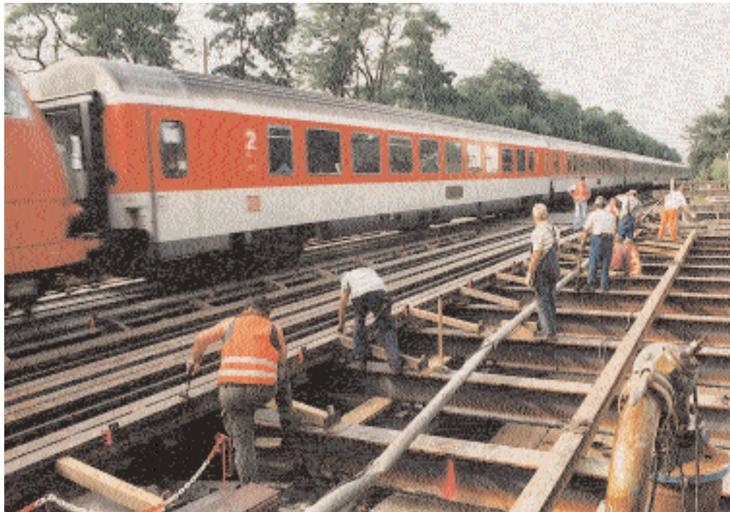
An allen vermessungstechnisch wichtigen Punkten waren Leica-Miniprismen angebracht. Sie sind hier neben den roten Klemmen deutlich zu erkennen. Foto: Gudrun Keese
