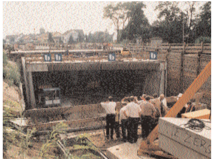
Das Verschiebrahmenelement wurde in einer 23 Meter entfernten Baugrube vorgefertigt. Foto: Gudrun Keese
