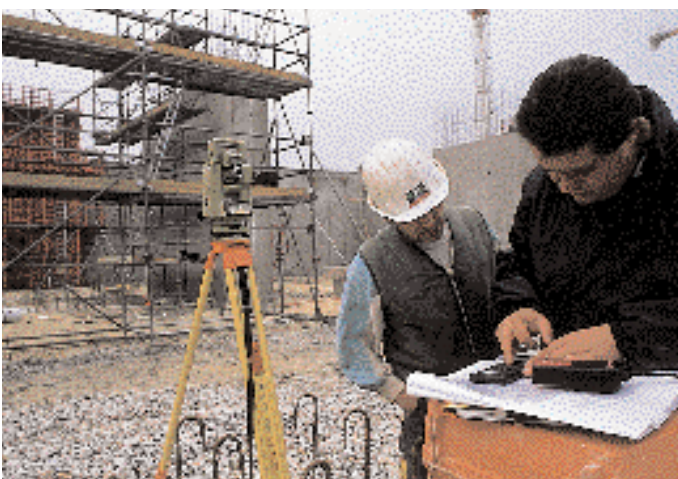
Links: Eine Schalungsposition wird mit Leica Theodolit und aufgesetztem DI1000 genau bestimmt.
